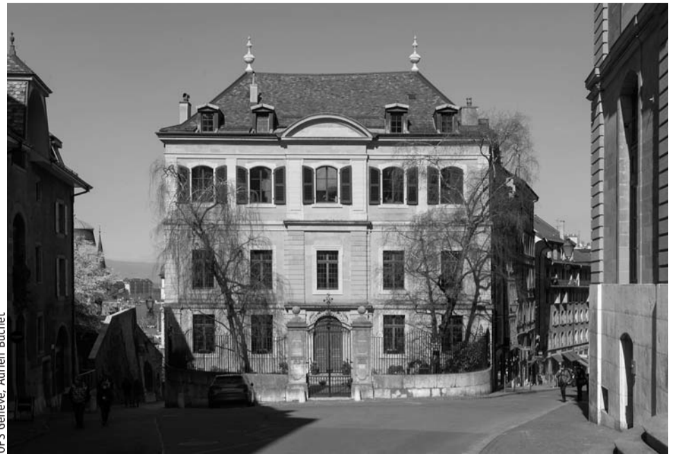
Façade principale de l'église luthérienne.
