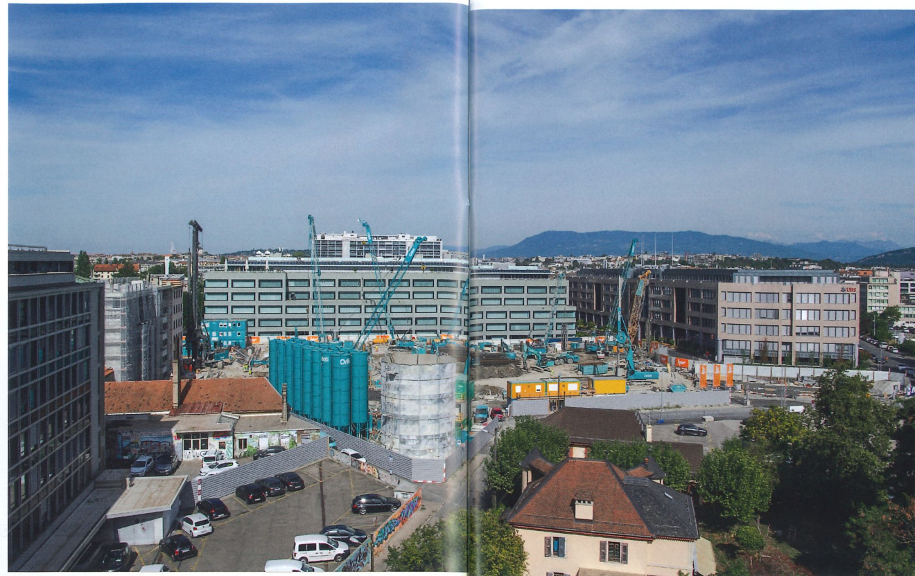
Le chantier de la banque privée Pictet. Un des premiers à démarrer dans le PAV.
