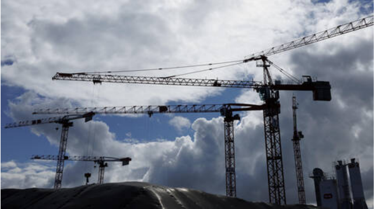
Des grues s'activent sur le chantier Quai des Vernets pour la construction d'immeubles dans le périmètre Praille Acacias Vernets (PAV), le lundi 8 mai 2023 à Genève. — © Salvatore Di Nolfi / Keystone
