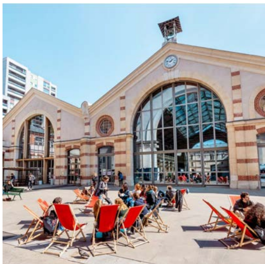
Profiter du soleil sur l'espace public (le 104, Paris)
