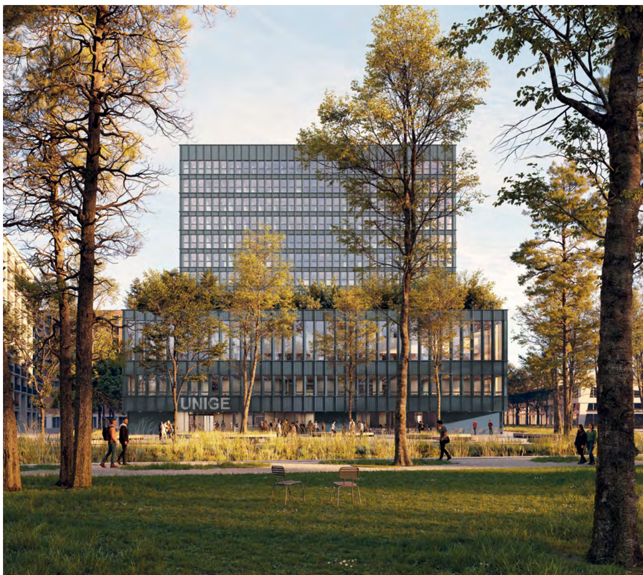
© UNIGE | Rue Hans-Wilsdorf, quartier des Vernets
