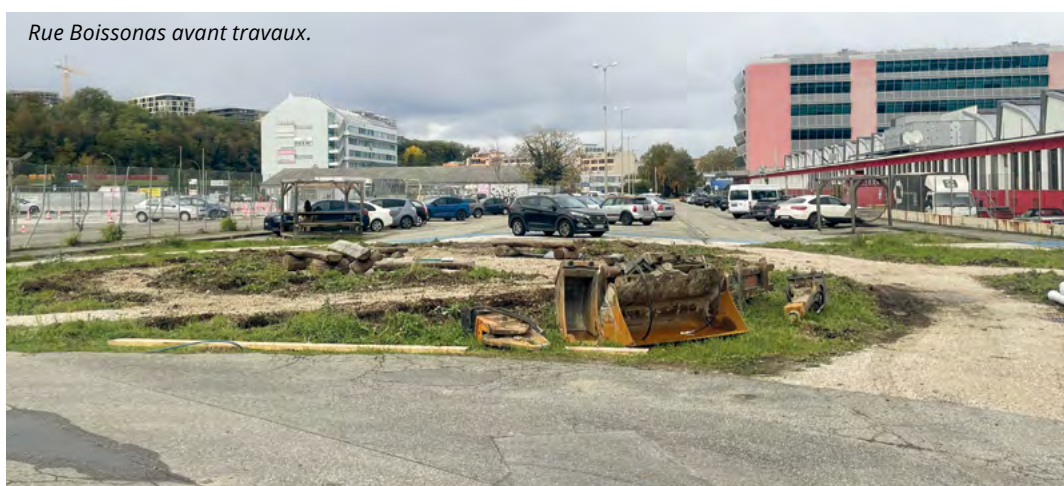
Rue Boissonas après travaux.
